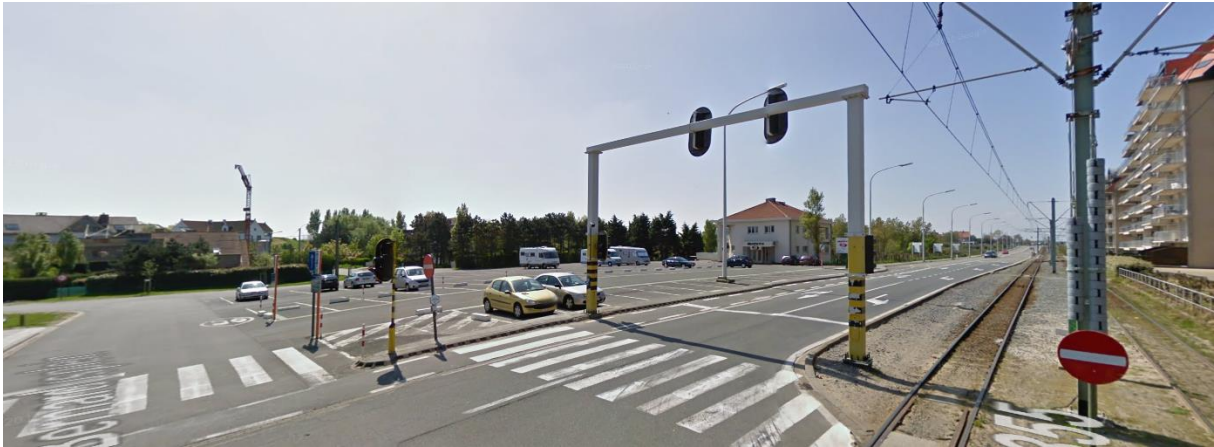
Figuur: ligging RUP Nieuwlandplein langsheen de N34z (bron: Google Street View).
