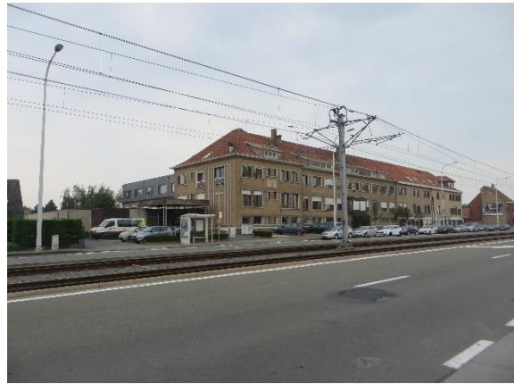
Foto 4: het rust- en verzorgingstehuis 'Ten Anker', langsheen de N34 (Albert I-laan)
