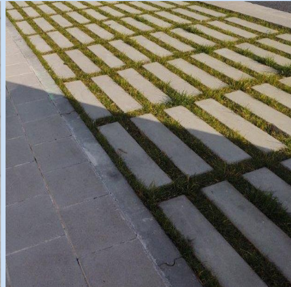
Opritten/parkings: lijnvormige betonnen grasdallen
