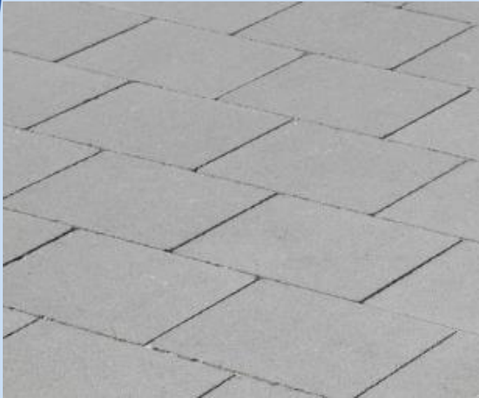
Voetpaden: grijze betonstraatstenen 22/22
