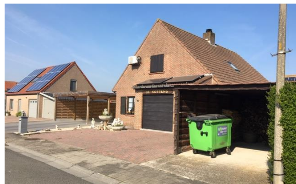
Foto 20: Pemenhoek ter illustratie volledig verharde voortuinen + carports (dd. 18/04/2019)
